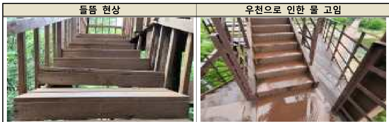
[그림11] 계단 관리 상태(미흡)
